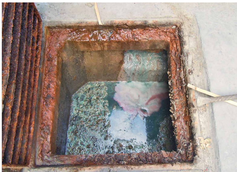
Aguas residuales de Monopol.
